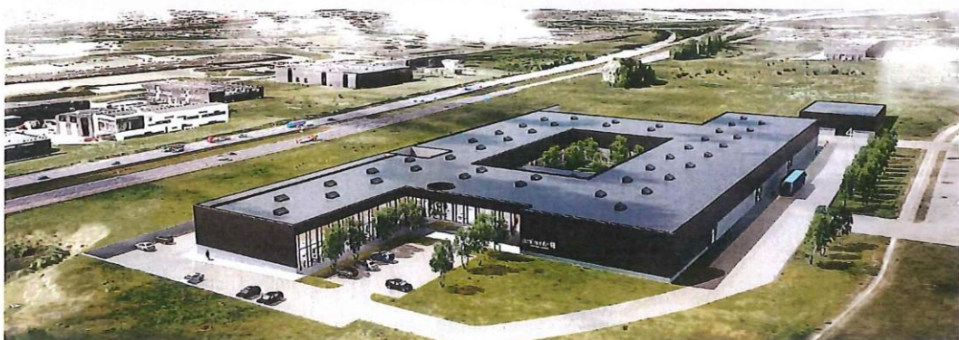
Messe- og indretningsfirmaet Ambiente er netop flyttet ind i sit splinternye firmadomicil, også udført af KT Erhvervsbyg A/S. Rending: Ardess.
