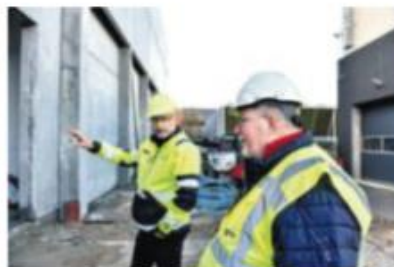
Bent Storgaard (tv.) og Anders Rønshof viser frem på byggepladsen og fortæller, hvordan man i projektet har forsøgt at tænke et skidt længere frem allerede nu. Blandt andet er rummet til den nye biomassekedel bygget så stort, at der er plads til en gang et tilsluttede en ekstra kedel, hvis der skulle blive behov for det. Foto: Ludvig Dittmann
