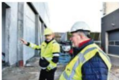
Bent Storgaard (tv.) og Anders Rønshof viser frem på byggepladsen og fortæller, hvordan man i projektet har forsøgt at tænke et skridt længere frem allerede nu. Blandt andet er rummet til den nye biomassekedel bygget så stort, at der er plads til engang et tilslutte en ekstra kedel, hvis der skulle blive behov for det. Foto: Ludvig Dittmann
