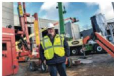
Anders Rønshof, formand for Egtved Varmeværk, er tilfreds med, hvordan byggeriet skrider frem. Han glæder sig nu til, at det nye anlæg kan tages i brug i starten af næste år. Foto: Ludvig Dittmann
