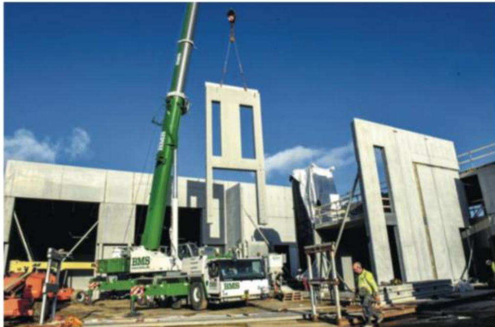
Det har været en spændende, men også udfordrende opgave at samle de mange betonelementer til det nye anlæg. Alle elementer er specialstøbt, og der er stort set ikke to, der er ens, fortæller projektchef Bent Storgaard. Foto: Ludvig Dittmann
